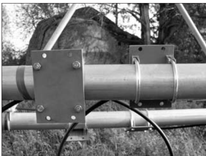
Kuva 6. Mastoonkiinnitysliaplat.
